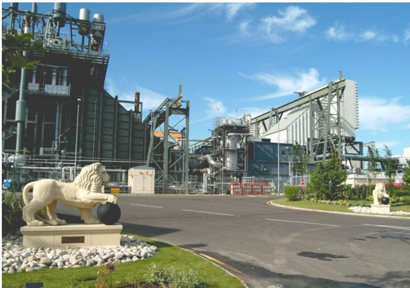
Paroplynová elektrárna Coryton, 45 kilometrů východně od Londýna
