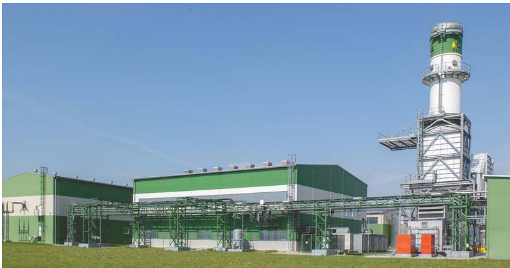
Prostějovská elektrárna slouží na vykrývání špiček – krátkodobého nedostatku energie v síti. Zdroj: UCED
